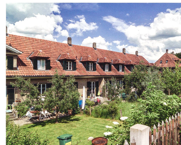
Die 212 Reiheneinfamilienhäuser unterscheiden sich sowohl in der Geschosshöhe als auch in den Details – und bilden doch eine Einheit.
