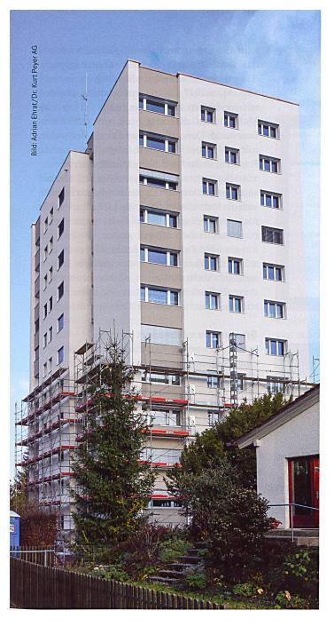
Die Hülle des Hochhauses aus den frühen 1960er-Jahren wurde komplett erneuert. Die Fassaden erhielten eine 16-Zentimeter-Steinwolldämmung.
