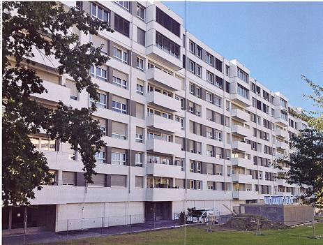
Das Scheibenhochhaus wurde um zwei Geschosse aufgestockt, die Fassaden wurden isoliert und erneuert. Links: früherer Zustand.
