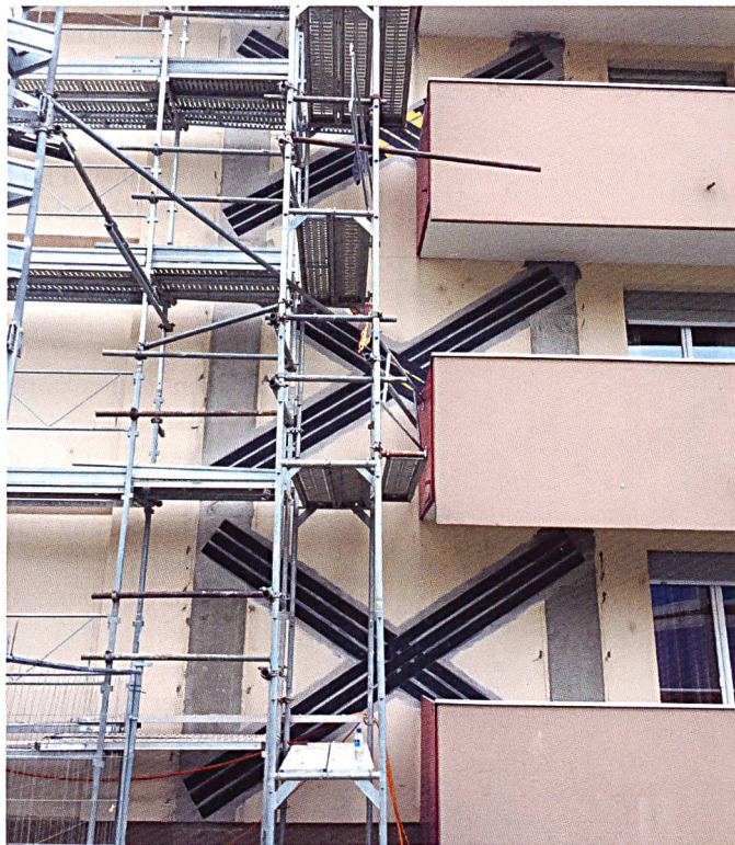
Kreuzweise eingesetzte Karbonstahllamellen sorgen für grössere Stabilität im Falle eines Erdbebens.
