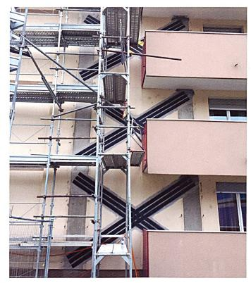
Kreuzweise eingesetzte Karbonstahllamellen sorgen für grössere Stabilität im Falle eines Erdbebens.
