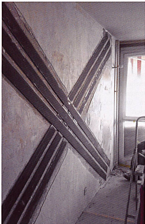
Kreuzweise eingesetzte Karbonstahllamellen sorgen für grössere Stabilität im Falle eines Erdbebens.
