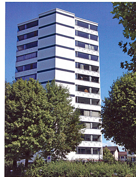
Das Gebäude erhielt eine neue hinterlüftete Fassade. Zudem wurden eine Reihe von Massnahmen zur Erdbebenertüchtigung ausgeführt.
