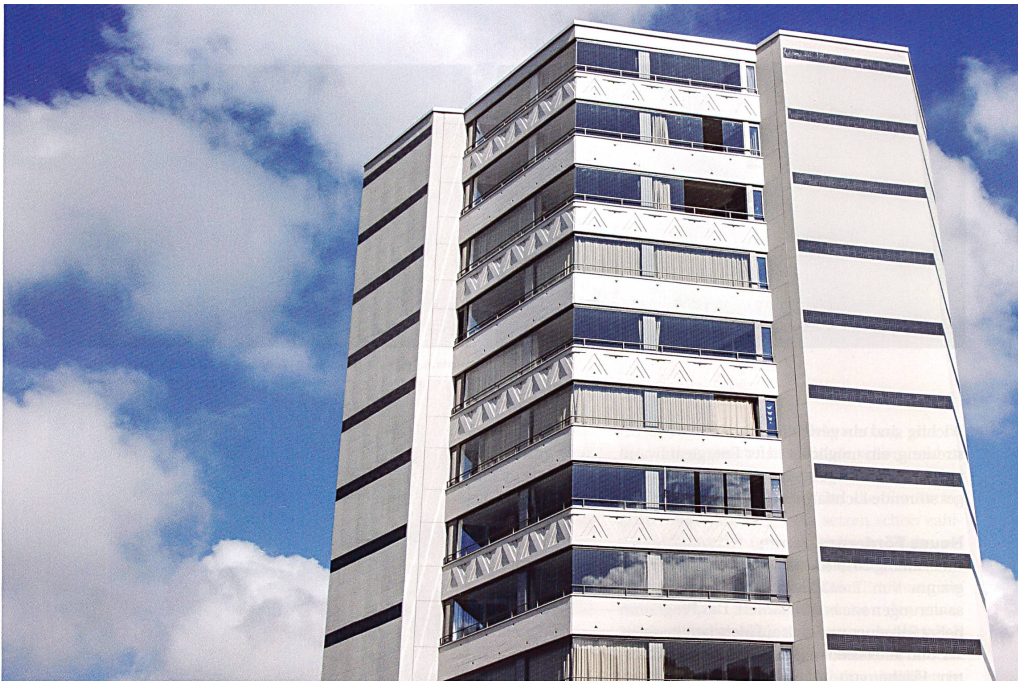
Das Hochhaus Fanghöfli ist im Inventar schützenswerter Bauten aufgeführt. Ersichtlich sind hier etwa die Ornamente an jeder zweiten Balkonbrüstung, eine Reverenz an den amerikanischen Architekten Frank Lloyd Wright.
