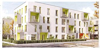
Musterhaus mit Modulen aus Stahlbeton und Zwischendecken in Holzleichtbaukonstruktion. Die Fassadengestaltung wird durch Loggiaelemente aufgewertet (Max Bögl Modul AG/Bögl Gierer Architekten GmbH/Stefan Lippert Architekten GmbH/pbb Planung + Projektsteuerungs GmbH).
