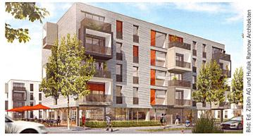
Musterhaus aus vorgefertigten Stahlbetonelementen, durch serielle und modulare Bauteile wie Fassadenelemente und Fertig-Nassraumzellen ergänzt (Ed. Züblin AG/Hullak Rannow Architekten GbR).
