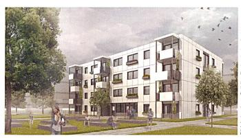
Holzbaukastensystem mit Stahlbetonkern mit industriellem Charakter des Fassadenbilds und sichtbarer Tragkonstruktion (Lukas Lang Building Technologies GmbH).
