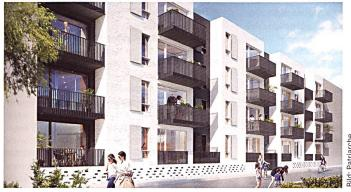
Modulbauweise aus vorfabrizierten, fertig ausgebauten und gebäudetiefen Modulen. Für die Fassadenverkleidung sind unterschiedliche Materialien wie Klinker, Putz und Faserzement möglich (MBN Bau AG/Patriarche Architectes Ingénieurs).
