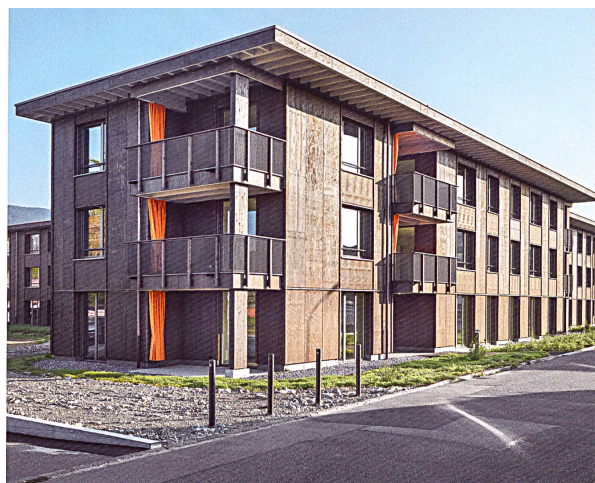
Um Verschmutzung und Alterserscheinungen vorzubeugen, sind die Fassadenplatten druckimprägniert und geölt.
