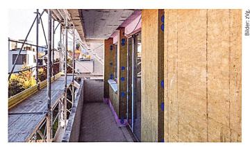
Um die Balkone nicht weiter zu verkleinern, wurde nordseitig aussen teilweise nur mit sechs Zentimetern gedämmt und dafür innen zusätzlich sechs Zentimeter Dämmung angebracht.
