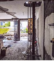
Die Sanierung erfolgte in unbewohntem Zustand. Weil die Erdbebensicherheit erhöht werden musste, wurden im Erdgeschoss vier Wände aus Mauerwerk durch solche aus Stahlbeton ersetzt.
