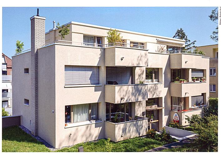
Trotz besserer Isolation hat sich die typische Optik des 60er-Jahre-Gebäudes kaum verändert; angebracht wurde eine 16 Zentimeter dicke Kompaktfassade, gedämmt wurde mit Steinwolle.
