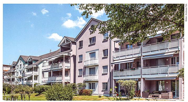
Die neue Minergie-Systemerneuerung umfasst fünf vordefinierte Sanierungsvarianten, die zum Minergie-Zertifikat führen. Beim gut 20-jährigen Mehrfamilienhaus in Schänis kam Systemvariante 2 zum Zug, bei der auf eine neue Dämmung der Gebäudehülle verzichtet werden konnte.
