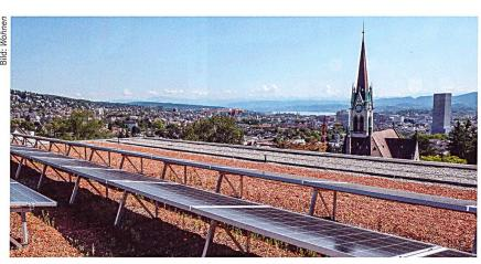
Alle Dächer sind mit PV-Anlagen ausgestattet, die Strom für die Wärmepumpen und die Bewohner liefern. Auf einem Haus erzeugen PVT-Hybridkollektoren zusätzlich Wärme zur Regeneration der Erdsonden.
