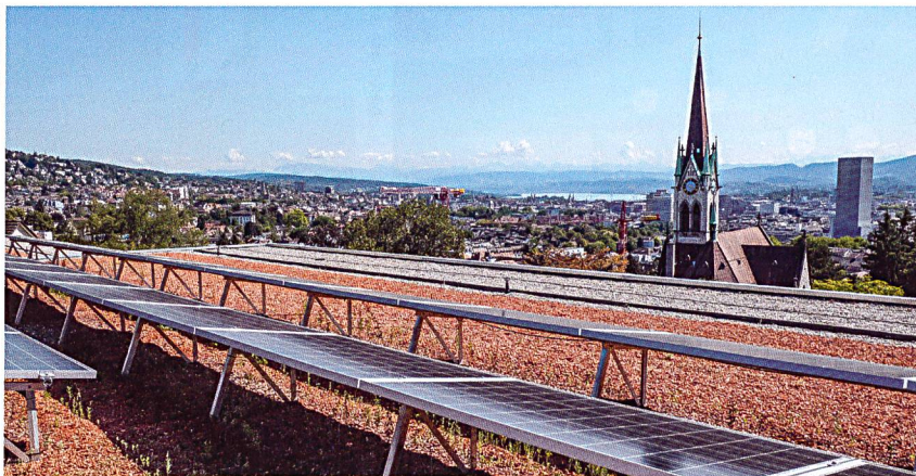
Alle Dächer sind mit PV-Anlagen ausgestattet, die Strom für die Wärmepumpen und die Bewohner liefern. Auf einem Haus erzeugen PVT-Hybridkollektoren zusätzlich Wärme zur Regeneration der Erdsonden.
