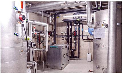
ewz-Projektleiter Pascal Leumann erklärt die verschiedenen Anlagen. Auf dem Bild links sind die schwarzen Erdsondenanschlussleitungen zu sehen, oben Warmwasserspeicher, Wärmepumpe und Pufferspeicher (von links).
