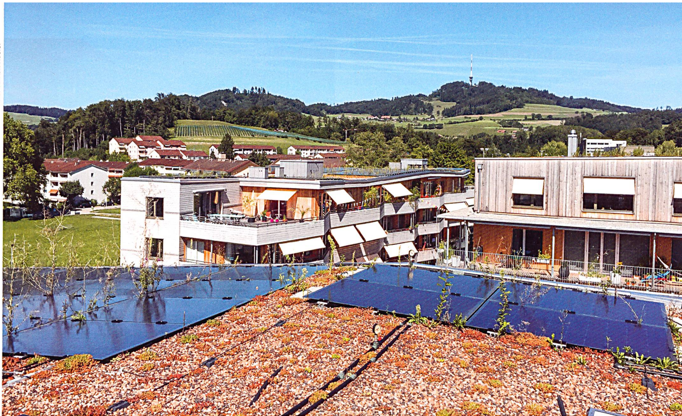
Die Wohnbaugenossenschaft Oberfeld in Ostermündigen (BE) gehört zu den genossenschaftlichen Pionieren, die PVT-Hybridkollektoren nutzen; diese produzieren gleichzeitig Strom und Wärme. In ihrer 2014 fertiggestellten Siedlung ist eine 1360 Quadratmeter grosse Anlage installiert.
