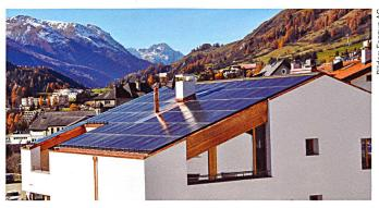
Bei der Siedlung Monolith in Scuol (GR) wird Solarwärme zur Regeneration des Erdspeichers eingesetzt. Durch verschiedene Anlagen wird getestet, welche Kombination von PV und Solarwärme die Nase vorn hat (siehe auch Beitrag Seite 18).
