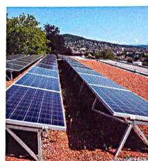
In der BEP-Siedlung Waid in Zürich werden verschiedene Systeme zur Wärmeerzeugung erprobt. Dabei liefern PV-Anlagen Strom für die Wärmepumpen, PVT-Hybridkollektoren zusätzlich Wärme zur Erdsondenregeneration.
