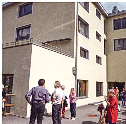
Alterswohnen in Schiers (GR).
