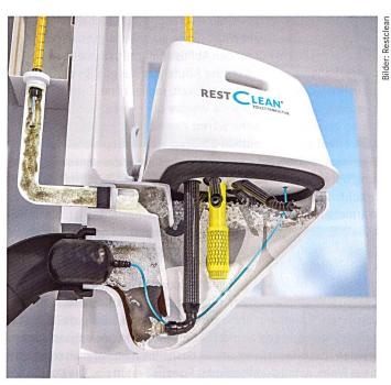
Alles abdichten, Düsen platzieren und los geht's: Während zwanzig bis dreissig Minuten wird die Restclean-Entkalkungslösung umgewälzt, bis sich der Kalk überall gelöst hat.
