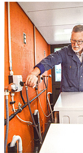
Die Wartung von Wasserinstallationen umfasst Anschlüsse und Leitungen ebenso wie die Kontrolle von Temperaturen und Drücken. Bild: Reparaturmann Hans Junker im Einsatz im Hochhaus Schwabgut der Eisenbahner-Baugenossenschaft Bern.
