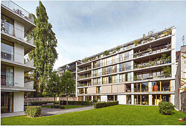
An der Elsässer- und der Fatiostrasse erstellte die Stiftung Habitat 2006 zwei Neubauten, die unterirdisch über einen gemeinsamen Garten verbunden sind. Das quartier- und sozialverträgliche Projekt richtet sich vor allem an Familien mit Kindern und Jugendlichen. Deren Mitwirkung ist ausdrücklich erwünscht.
