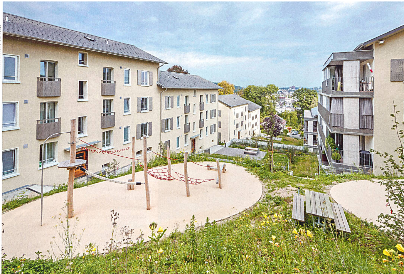
Das Erscheinungsbild der Siedlung Weinbergli, die teils unter Ortsschutz steht, blieb erhalten. Die Eingangsseite wurde wärmetechnisch saniert, auf der Balkonseite erstellte man 2,5 Meter tiefe Anbauten.
