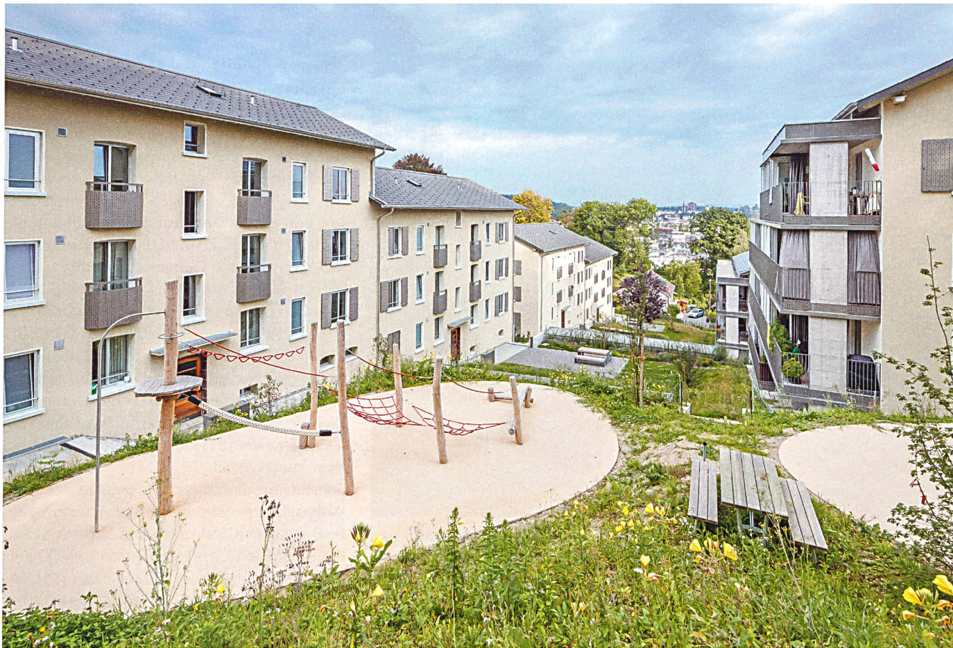
Das Erscheinungsbild der Siedlung Weinbergli, die teils unter Ortsschutz steht, blieb erhalten. Die Eingangsseite wurde wärmetechnisch saniert, auf der Balkonseite erstellte man 2,5 Meter tiefe Anbauten.
