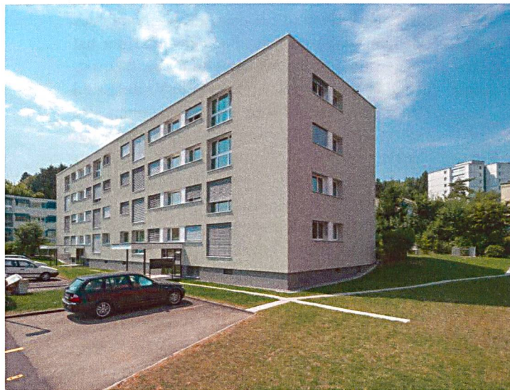
Gesamtsanierung MFH Am Brunnenbächli in Zollikerberg
