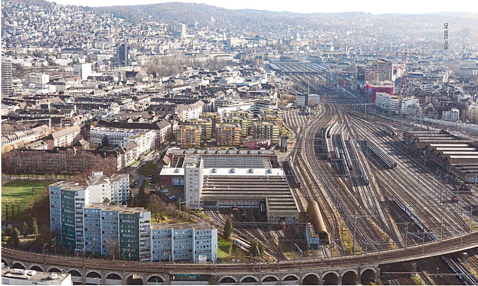
Das Areal Neugasse (Bildmitte) grenzt an das Schienefeld vor dem Zürcher Hauptbahnhof, den Viadukt und die Josefwiese. Im Vordergrund links die Wohnsiedlung der Eisenbahner Baugenossenschaft Dreispitz.
