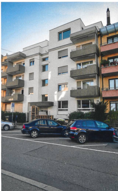
Das Haus an der Friesstrasse 35 in Zürich Oerlikon bietet dank der Aufstockung neu eine 10-Zimmer-Attikawohnung.
