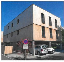
Bei den Häusern in Rankweil kam die Holz-Beton-Verbundbauweise zum Einsatz.
