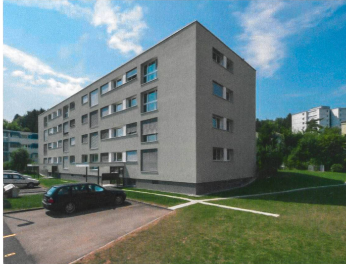
Gesamtsanierung MFH Am Brunnenbächli in Zollikerberg
