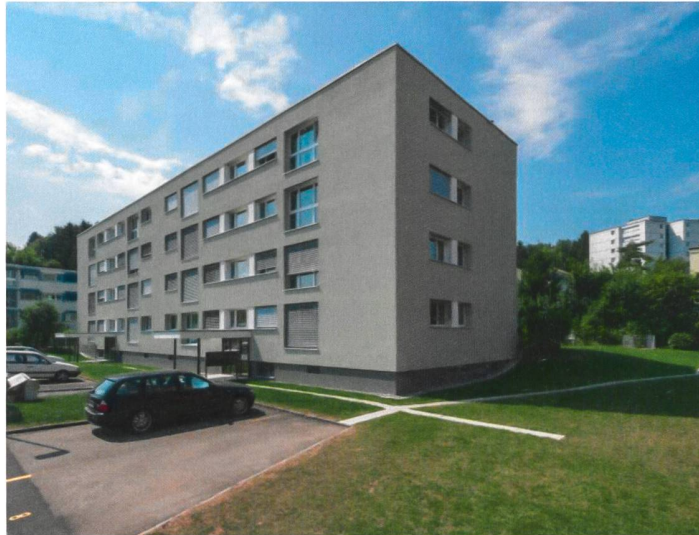
Gesamtsanierung MFH Am Brunnenbächli in Zollikerberg
