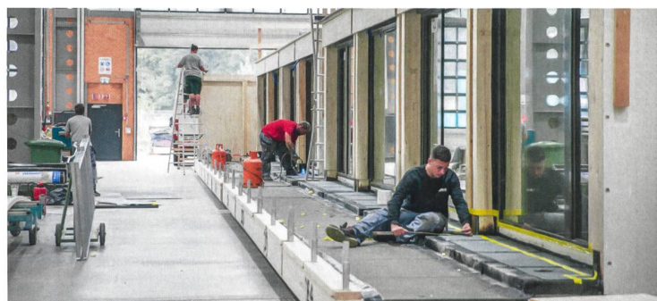
Vorgefertigt von der Photovoltaikanlage bis zum Parkett: Blick in die Produktion der Zimmermodule im Werk der Häring AG in Eiken.
