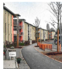
Die Ersatzneubauten der Baugenossenschaft Schönau in Zürich Seebach fügen sich ins Bild der Dorfsiedlung. Bild: Katja Jug
