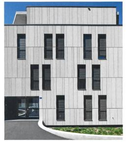
Bei den Fassaden handelt es sich um eine hinterlüftete Konstruktion, die mit Terrakottaplatten verkleidet ist.
