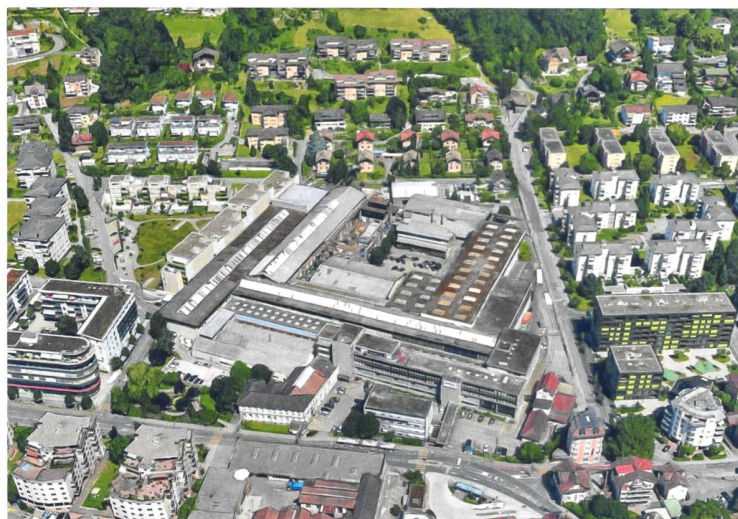
Auf dem Andritz-Areal in Kriens (LU) plant die Logis Suisse AG ein neues Quartier mit 450 Wohnungen und Gewerbenutzungen.
