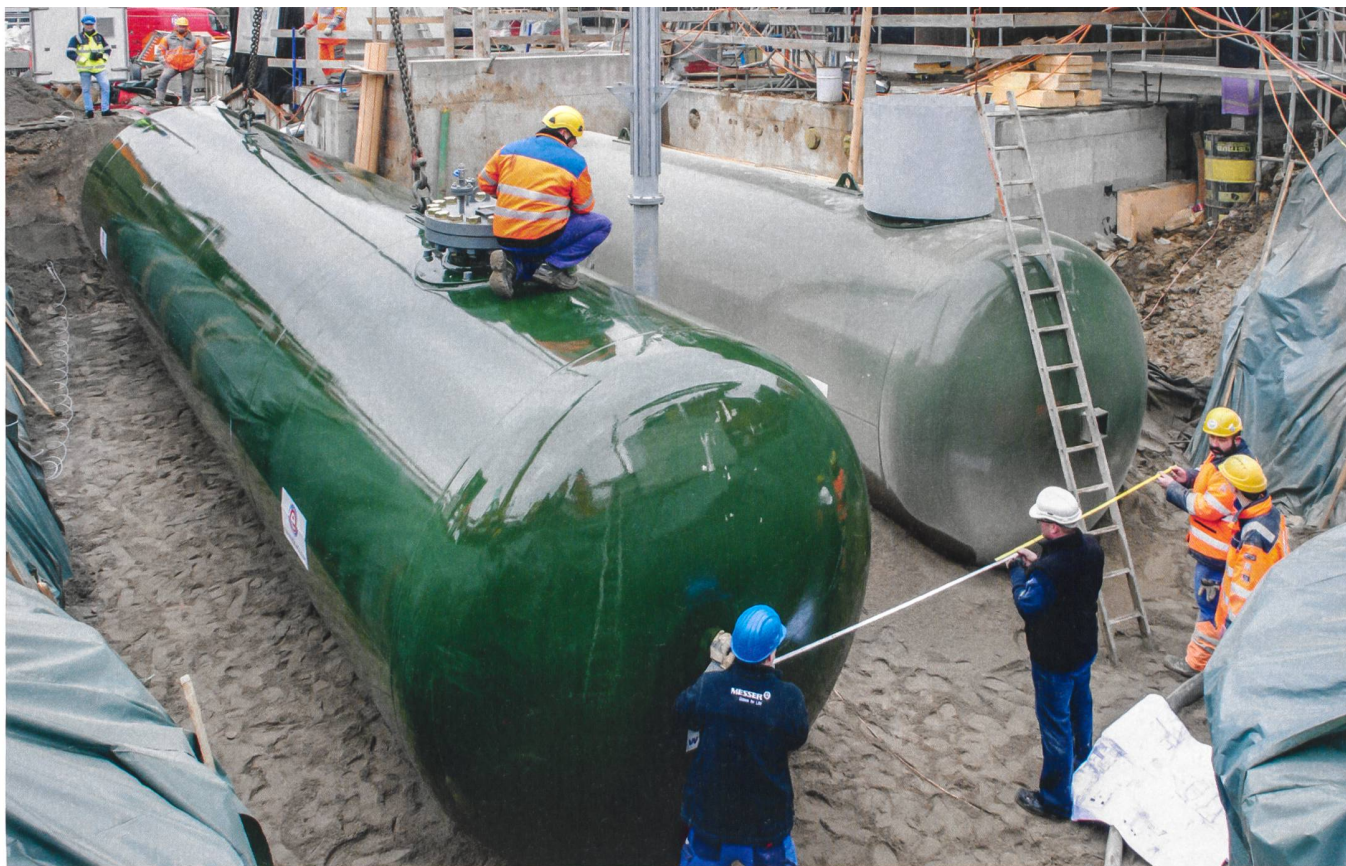
Beim energieautarken Mehrfamilienhaus in Brütten (ZH) wird überschüssiger Solarstrom in Wasserstofftanks gespeichert, sobald die Lithiumbatterien voll sind. Das Bild zeigt das Einsetzen der Tanks in den Boden.
