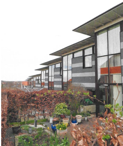
Die Überbauung Grønhøj mit ihren Sozialwohnungen ist Teil eines Quartiers, in dem sich Eigentums- und Wohnungstypen abwechseln.
