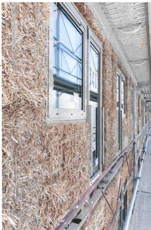
Das Stroh für die Isolierung ist in Elemente eingefügt, die aus Holz und Lehm bestehen. Bei der Vorfertigung arbeiteten Genossenschaftsmitglieder unentgeltlich mit.
