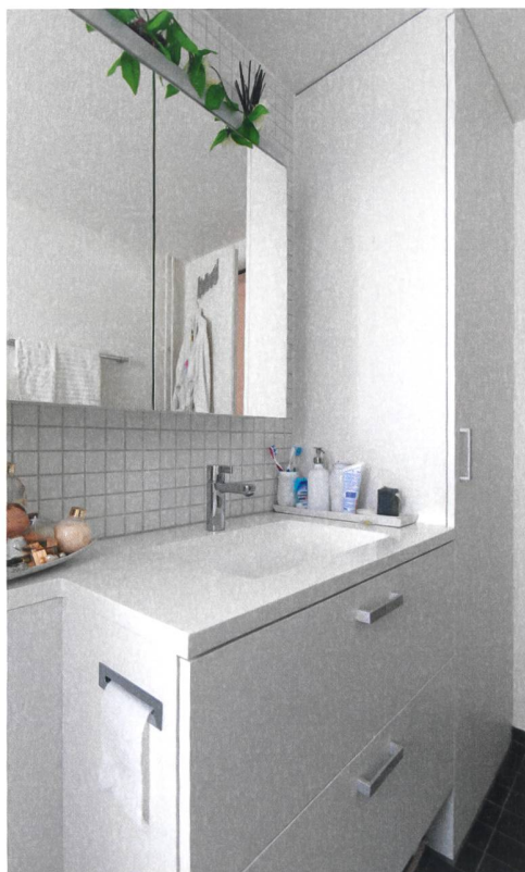
Der Werkstoff Corian hat sich wegen seiner Dauerhaftigkeit bei den Waschtischen bewährt.
