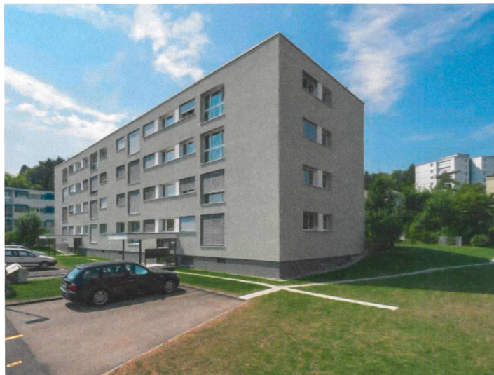
Gesamtsanierung MFH Am Brunnenbächli in Zollikerberg
