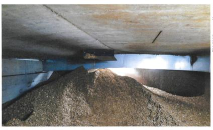
Blick in das Schnitzelsilo. Zeigt der Sensor im Bunker an, dass die Schnitzel knapp werden, wird direkt der Lieferant benachrichtigt. Abgerechnet wird pro Kilowattstunde Leistung.
