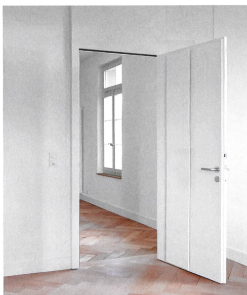
Ursprünglich für Sanierungen entwickelt, kommen heute Überströmer auch bei Neubauten zum Einsatz. Im Bild Beispiel einer türintegrierten Variante.
