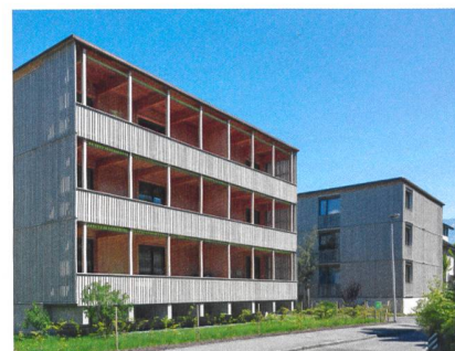
Die beiden Bauten bieten insgesamt 18 Wohnungen. Das Hochparterre ist im Rheintal wegen der Grundwassersituation weit verbreitet.
