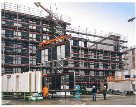
Die Holzrahmenelemente für die drei Bauten auf dem Freilager-Areal lieferte Renggli vorgefertigt auf die Baustelle. Fertigung, Montage und Logistik mussten präzis abgestimmt werden.
