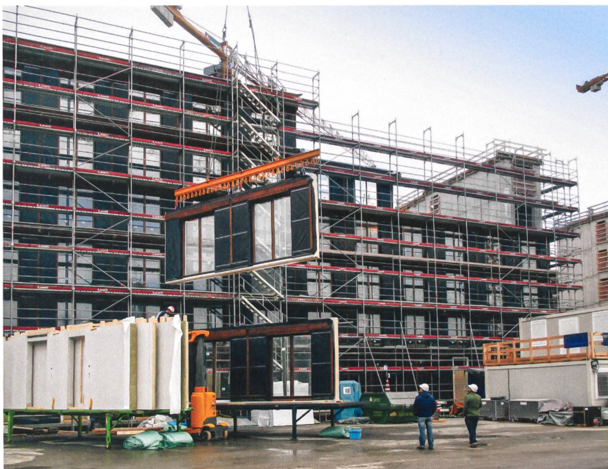
Die Holzrahmenelemente für die drei Bauten auf dem Freilager-Areal lieferte Renggli vorgefertigt auf die Baustelle. Fertigung, Montage und Logistik mussten präzise abgestimmt werden.
