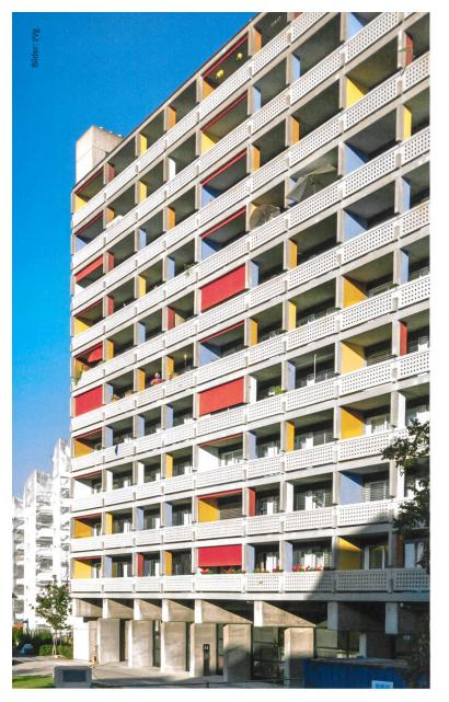
Das Hochhaus nach der Sanierung: Die Brüstungsbänder aus Beton konnten trotz Denkmalschutz durch eine leichtere, perforierte Version ersetzt werden. Ersichtlich sind auch die neue Farbgestaltung im Balkonbereich sowie das geschützte Sockelgeschoss.
