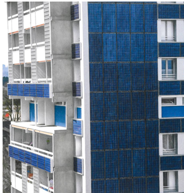
1200 Photovoltaikmodule bedecken die Fassade.
