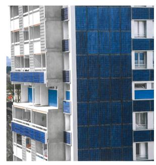
1200 Photovoltaikelemente bedecken die Fassade.
