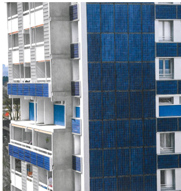
1200 Photovoltaikmodule bedecken die Fassade.
