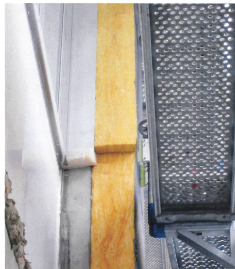
Dank neuer Dreifachverglasung (mit integrierter Store) und Wärmedämmung erreicht das Hochhaus Minergie-P-Werte.
