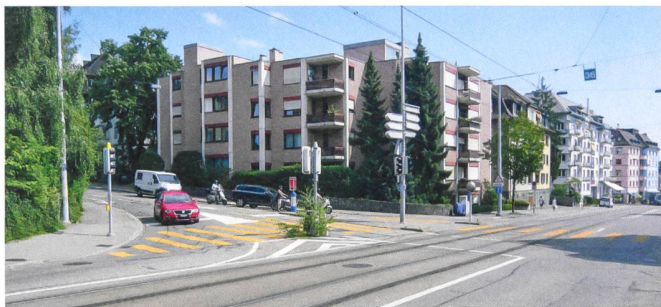
Der Gebäudekomplex an der Hofwiesenstrasse vor dem Umbau.
