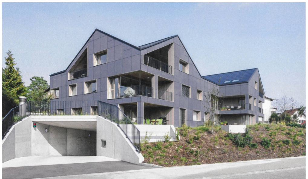
Das erste energieautarke Mehrfamilienhaus der Schweiz in Brütten (ZH): Die Aussenhaut besteht aus hinterlüfteten Glasplatten, in die rahmenlose Photovoltaikmodule integriert sind.
