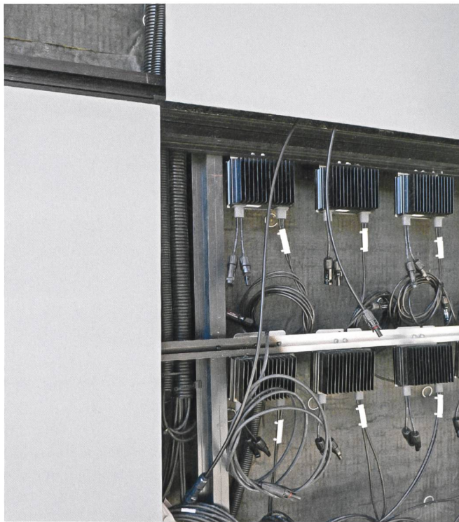
Hinter dem Deckglas befinden sich die PV-Zellen.
