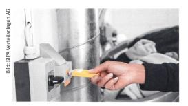
Die Baugenossenschaften, die für diesen Beitrag angefragt wurden, setzten am häufigsten auf ein Stromzählerumschaltsystem, das die Waschkosten dem jeweiligen Wohnungsstromzähler belastet. Die Umschaltung funktioniert mittels Kartenlesegerät.
