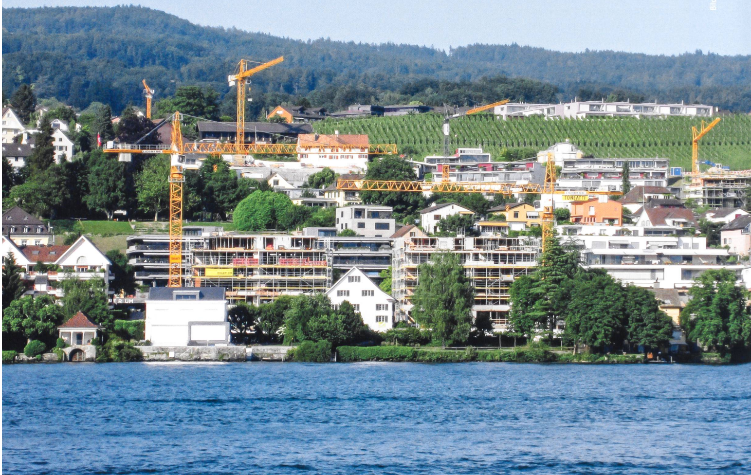
Das revidierte Raumplanungsgesetz hat zum Ziel, der weiteren Zersiedelung der Schweiz entgegenzuwirken. Bild: Stäfa am Zürichsee, wo der Rebberg immer mehr überbaut wird.
