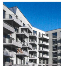
Die zentrumsnahe städtische Überbauung Kronenwiese in Zürich zeigt, wie Verdichtung und hohe ökologische Standards Hand in Hand gehen. Bild: Giorgio von Arb
