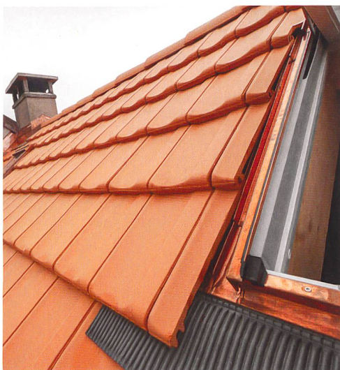
Blick auf ein erneuertes Dach.
