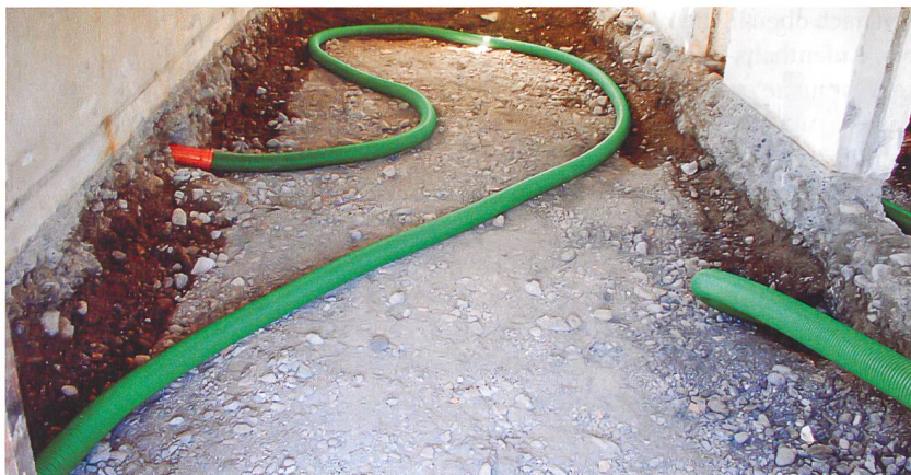
Einbau einer Radondrainage im Rahmen einer Erneuerung des Fussbodenaufbaus.
