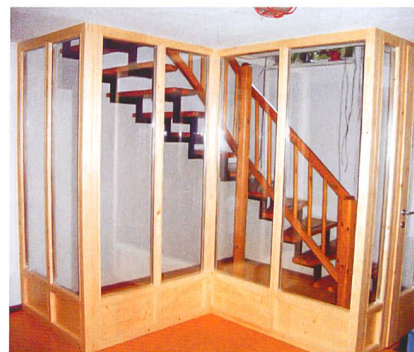
Schutz vor Radon kann eine Abdichtung des Kelleraufganges bieten (Bilder vorher und nachher).
