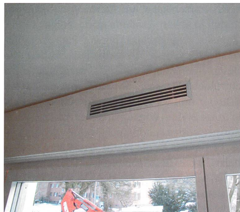
Der Einbau einer Komfortlüftung kann das Radonproblem lösen.
