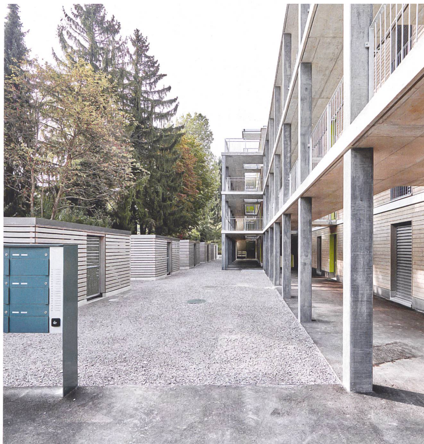
Die Erschliessung erfolgt über Laubgänge, die etwas von der Fassade abgesetzt sind.
