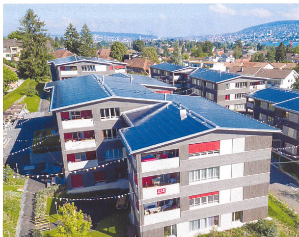
Die Photovoltaikanlage erzeugt mehr Strom, als die ABZ-Neubausiedlung Balberstrasse verbraucht.
