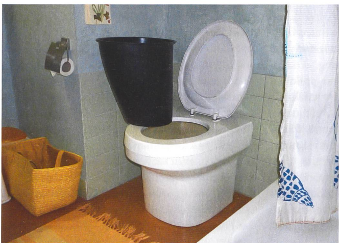
Das Innere des WCs kann bei Bedarf zur Reinigung entnommen werden.
