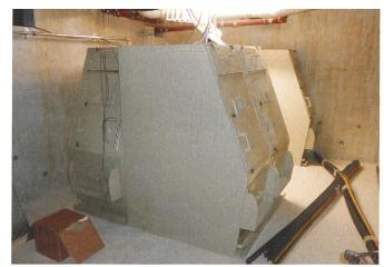
Hier wird aber nicht mit Wasser gespült. Vielmehr landen Fäkalien und Urin über ein Rohr direkt in einem Kompostierbehälter im Keller.
