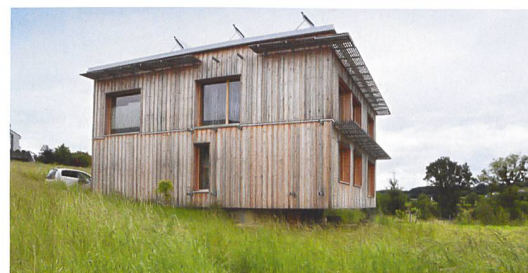
Kein übliches Holzhaus: Die Wände sind mit Strohballen und weiteren natürlichen Materialien gedämmt.
