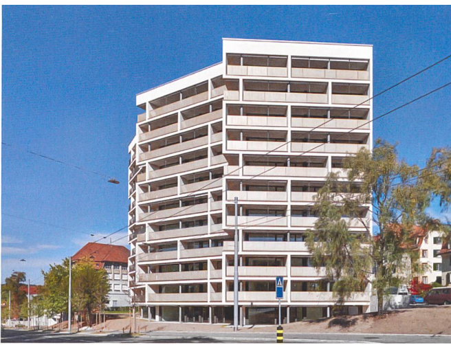
Das SAW-Hochhaus Scheuchzerstrasse wurde auf der Süd- und der Westseite durch eine vorgelagerte Gebäudeschicht mit Balkonen erweitert.
