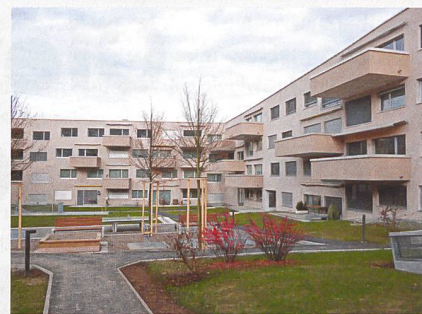
In der ganzen Siedlung wurde Glas verwendet, das wenig Wärmeeinstrahlung durchlässt, in den unteren beiden Stockwerken zudem Sicherheitsglas.
