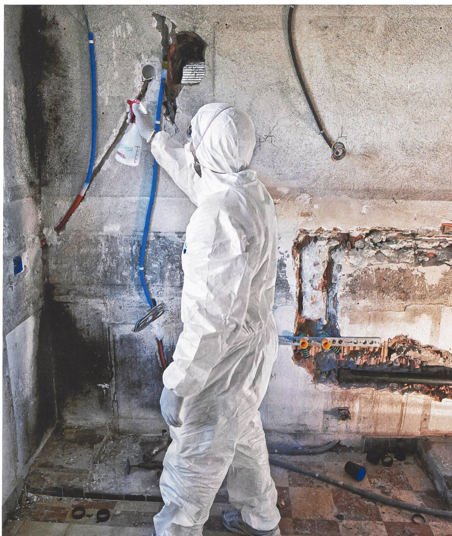
Bei einer umfassenden Schimmelpilzsanierung kommen Putzfräse und Industriesauger zum Einsatz.
