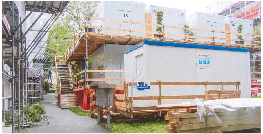
Das kleine Containerdorf schafft neue Kontakte unter der Mieterschaft.
